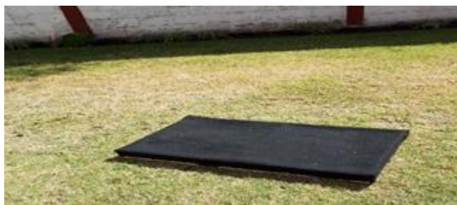
Figura 6. Colocación del geotextil
