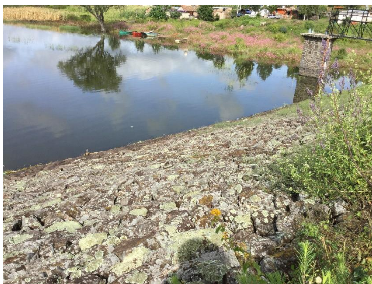
Figura 1. Cortina de la presa El Volantín
