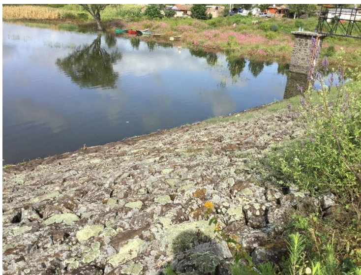
Figura 1. Cortina de la presa El Volantín
